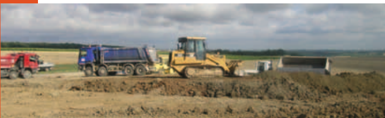
Einbau der Rekultivierungsschicht im Juli 2013 (Foto: Hardy Rückert)
